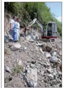
DER JOHANNESSTEIG beim Schweizerhaus wird saniert.
